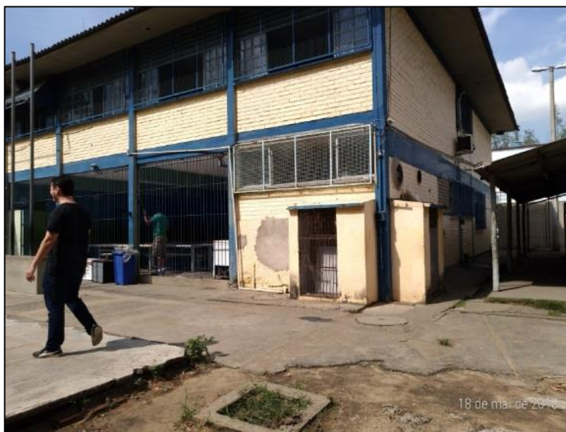
Figura 1 - Foto dos fundos da escola, piso da quadra e piso do pátio externo degradados.
