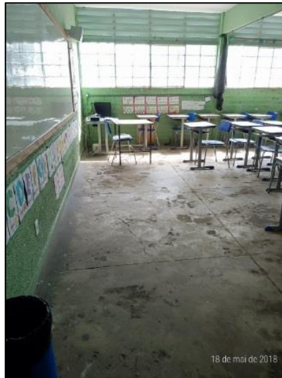
Figura 2 - Foto do piso de uma das salas de aula.
