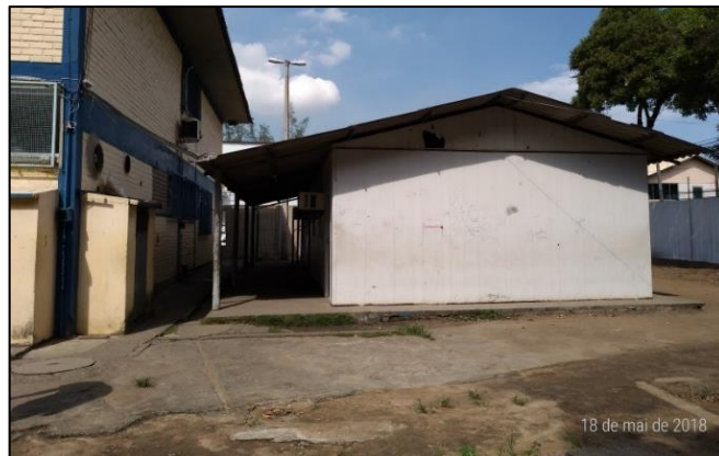
Figura 3 - Foto do anexo de salas de aulas provisórias, fora de contexto.
