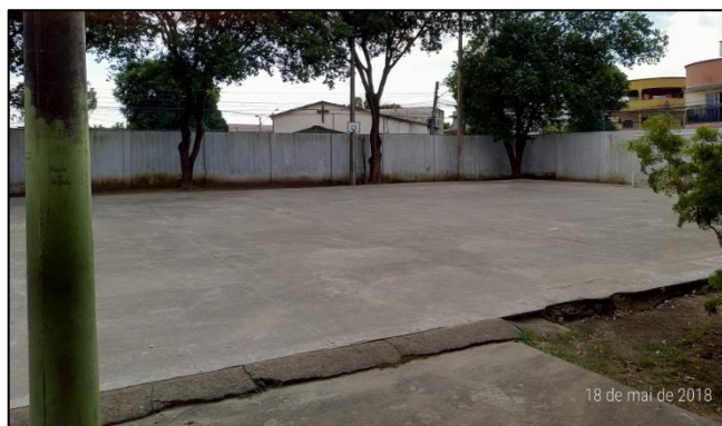
Figura 5 - Piso da quadra interditada descoberta.
