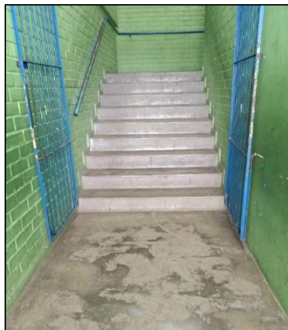
Figura 4 - Foto da escada, único acesso ao pavimento superior.
